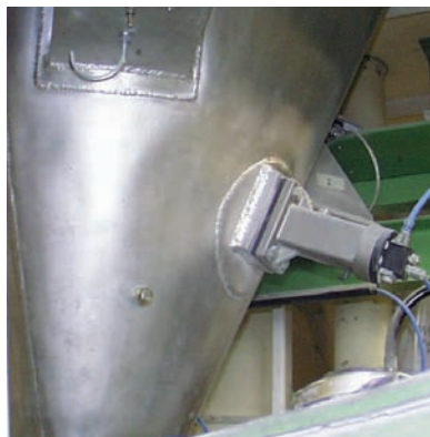
Abreinen von Bunkerwänden
